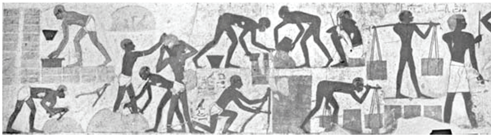
Figura I.1.2. – Verifica della caratteristica qualitativa “perpendicolarità” di un blocco di pietra
